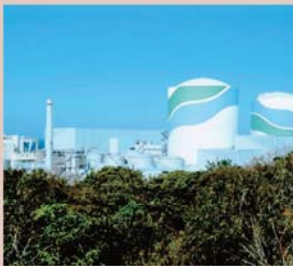
原子力発電所
